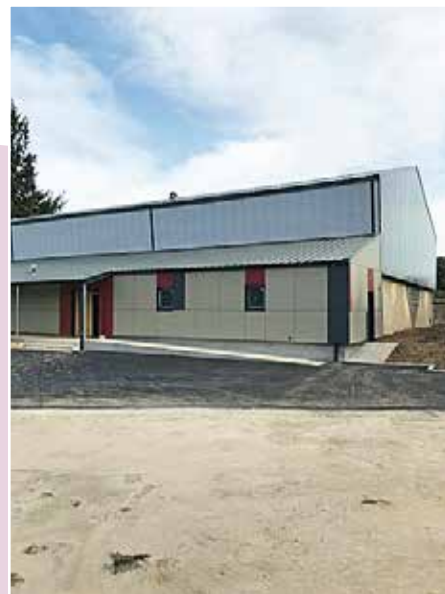
Travaux salle de sports des Hairies : réalisation d'enrobés devant la salle, les souches ont été enlevées et le gazon sera réalisé en régie par les agents.
