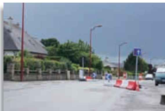
Travaux de ralentissement
