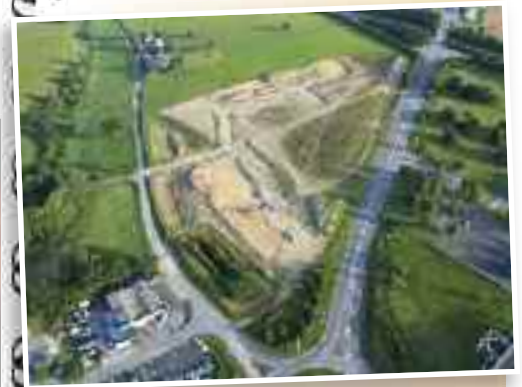
Travaux Piquet ouest
