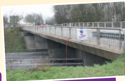
Fin des travaux de Piquet
