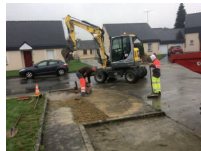
Travaux du secteur de la Moutaudière
