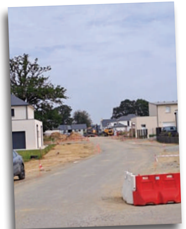
ZAC de la Plesse : finition de la placette de la tranche 2 et de la voirie de la tranche 3 en cours. 6 conteneurs à déchets seront installés fin septembre.
