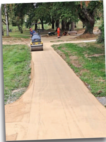
Réfection des allées à la Prévalaye suite aux travaux d'assainissement. La reprise des espaces verts devrait suivre.
