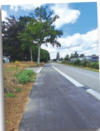
Ouverture de la piste cyclable et égaleme n t de la voie Etrellles Argentré. Il restera quelques finitions et la signalisation.
