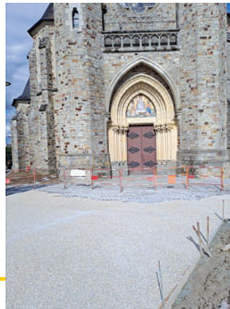
Béton désactivé coulé devant l'église et cheminement piéton en cours.
